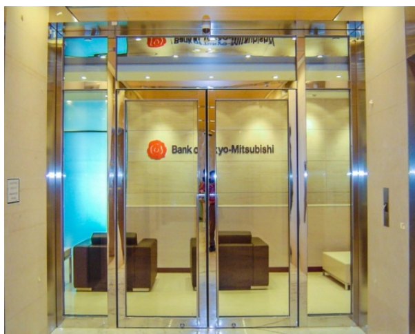
防火玻璃門連頂部加兩側防火玻璃間隔
