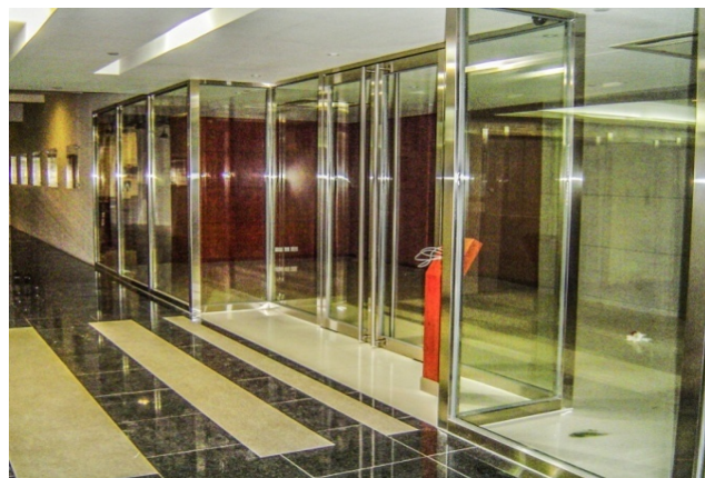
圖書館防火玻璃門連防火玻璃牆
